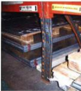
Exemples de montant ayant subi une déformation importante présentant un risque d'effondrement
